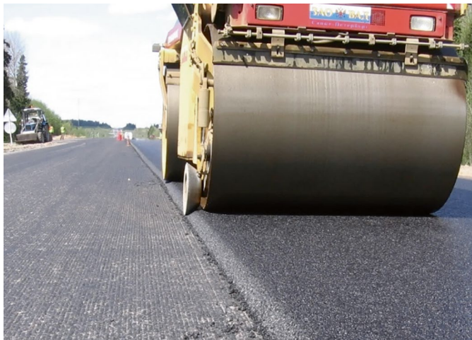
Рис 5. Уплотнение кромки укладываемого слоя асфальтобетона с помощью прижимного вальца
