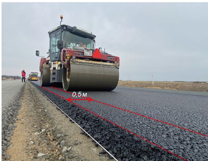
Рис 6. Увеличение ширины уплотняемой поверхности при использовании катка со смещенным вальцом
